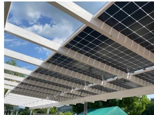
Doppelglas Module (zertifiziert nach EN12600 zur Überkopfmontage)
