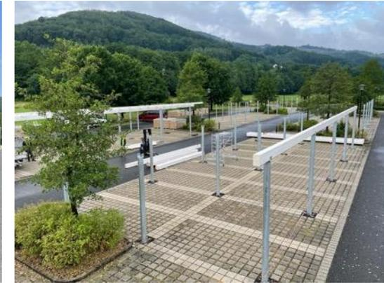
Unterzüge bieten Stabilität für die Konstruktion. Stützen-Befestigung variabel an den Unterzügen
