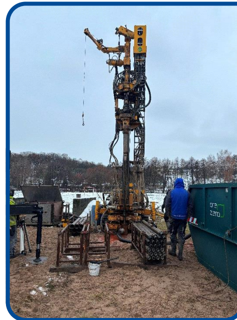
Bild des Bohrgestänges der Probebohrung
