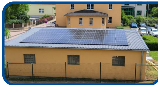
PVA Betriebshof auf dem Gaslager
